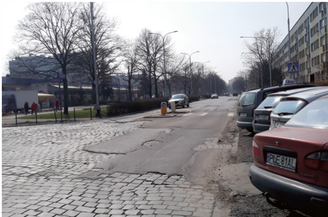
Jezdnia na Komandorskiej jest popękana i miejscami zapadła się kostka, jej remont potrwa 3 m-ce
