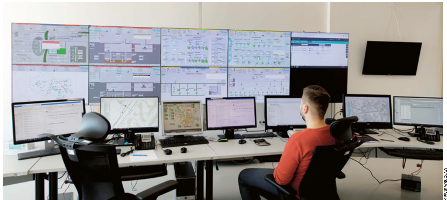
Centrum Zarządzania Operacyjnego MPWiK Wrocław. Na monitorach widać aktualne zużycie wody w różnych miejscach Wrocławia
